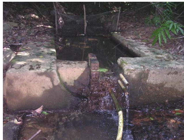
38. Bể tích nước suối Bà Đầm (độ cao 150m)
