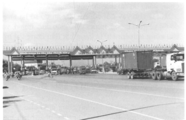
Trạm thu phí do Quỹ Hạ tầng Tp. HCM tài trợ
