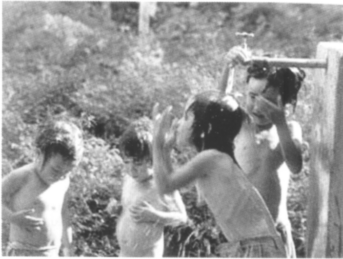
Đầu tư cấp nước nông thôn nhằm xóa đói giảm nghèo
