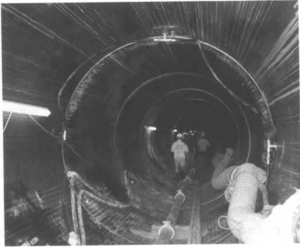
Cống thái đang được xây dựng ở thành phố Hồ Chí Minh
