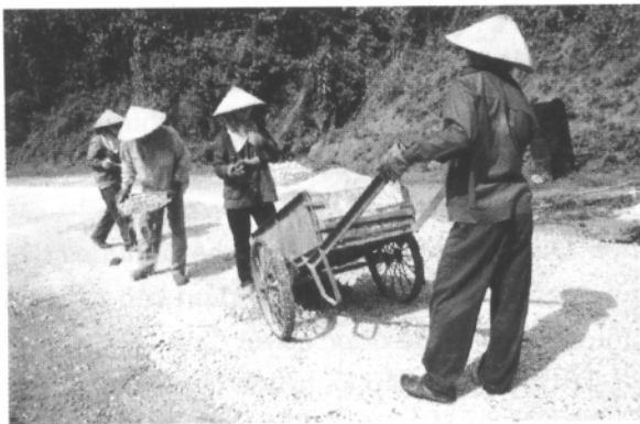
Báo dưỡng đường bộ
